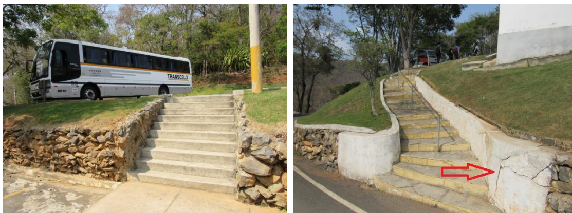
Conjunto de imagens 21 - Escada de acesso área de convivência - Fonte: IEF/MG
