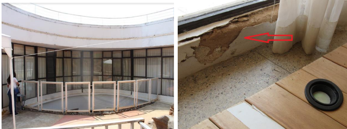
Conjunto de imagens 4 - Esquadrias metálicas - Fonte: IEF/MG
