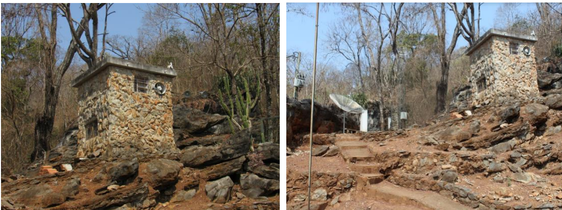
Conjunto de imagens 24 - Sala de maquinas - Fonte: IEF/MG
