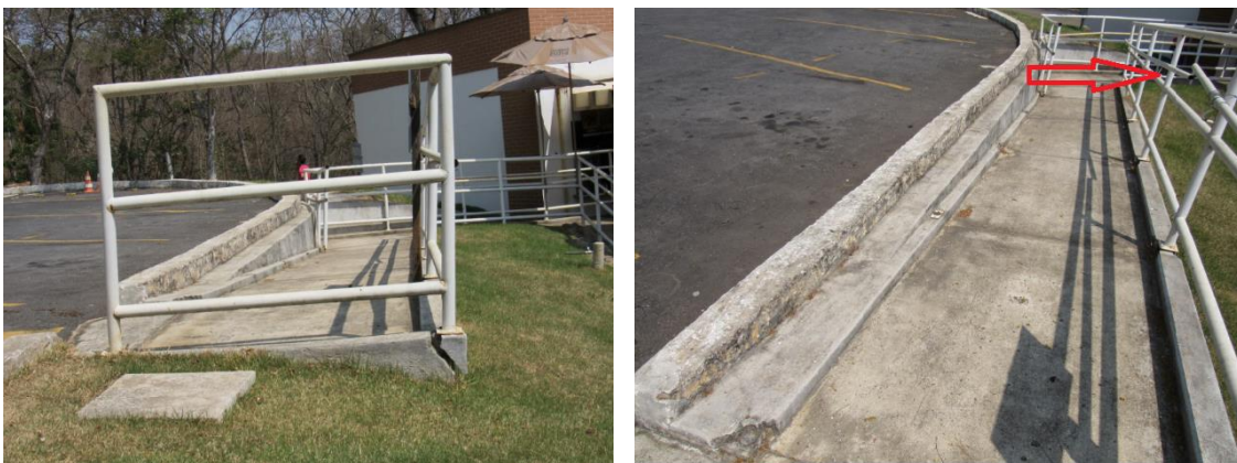
Conjunto de imagens 20 – Rampa acessível -- Fonte: IEF/MG
